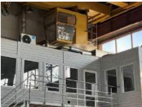
Kopskats – Ventilācijas iekārta ar apsaisti / Siltumsūkņis – ārējais bloks MIDEA
